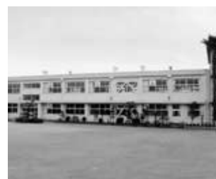
▲志都美小学校耐震補強
