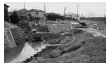
▲葛下川改修工事
