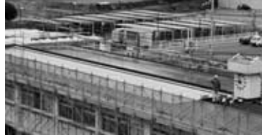
▲太陽光発電パネル設置工事
