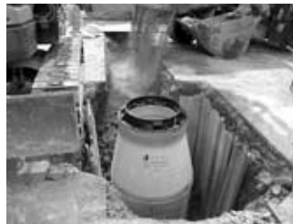
▲下水道整備工事
