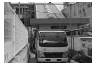
▲エレベーターの設置工事 (近鉄五位堂駅)
