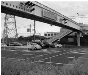
▲真美ヶ丘第1歩道橋
