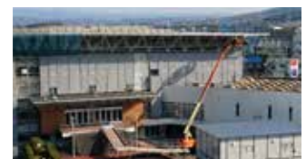
総合体育館耐震改修工事
