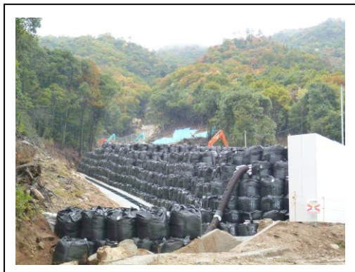
①土石流発生現場での災害復旧状況
