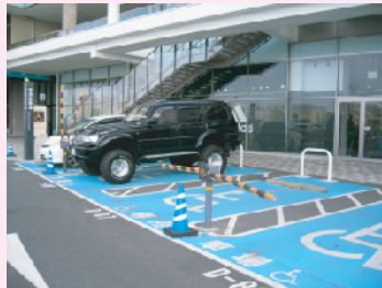
個別区画型専用ゲートを設置した駐車場
