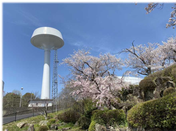
香芝市上下水道部・今泉配水場
