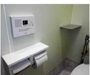
どのトイレも個室には、教科書などを置くための書類置き棚が設置されています。入口に最も近い小便器と個室には手すりが設置されています。蛇口・照明・換気扇のオンオフ、小便器の洗浄はすべて自動となっています。
