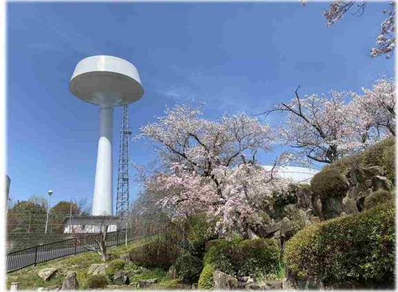
香芝市上下水道部・今泉配水場
