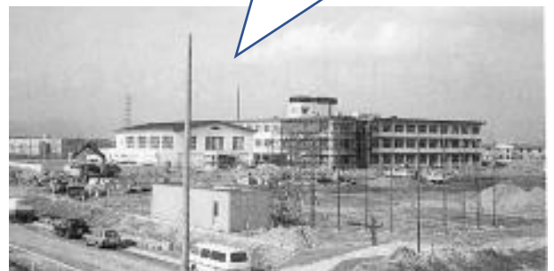
【工事中の真美ヶ丘東小学校】
