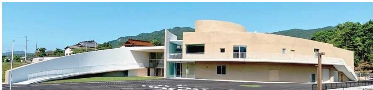
熊野東防災交流センター
