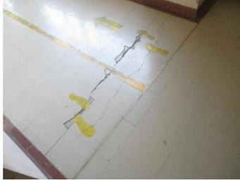
床の長尺シートがひび割れている。段差等により、児童・生徒がケガをする恐れがある。
