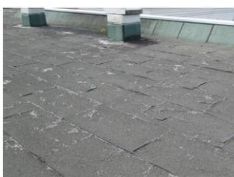
屋上防水シートに表面の摩耗劣化が見られる。
