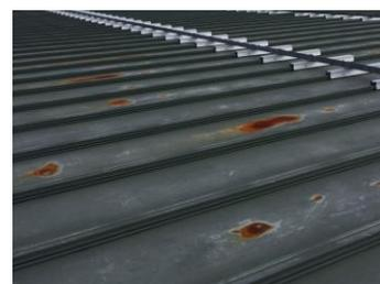
屋内運動場等の金属屋根面に発錆が見られる。腐食が進行すると、雨漏りし、屋根の葺き替えが必要となる。
