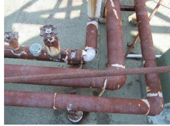
配管カバーが発錆により破損している。
