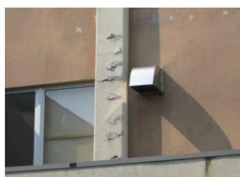
外壁の柱部に鉄筋に沿ってコンクリートの剥離が見られる。落下すると危険なため、早急な処置が必要。
