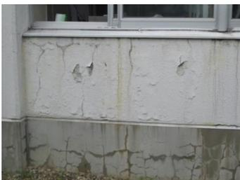
外壁にひび割れや、塗装の剥離が見られる。漏水や、コンクリート強度に影響が出るため早急な処置が必要。
