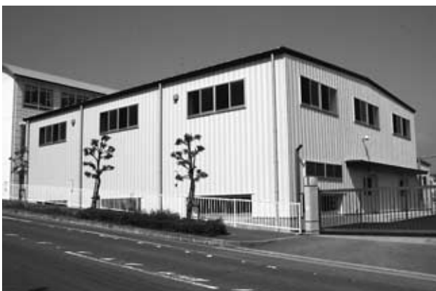
▲完成したサブ体育館
