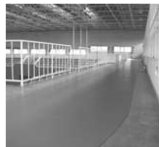
▶完成したランニング走路
