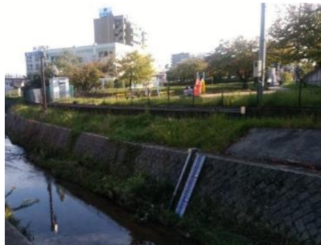
瓦口水位観測所
