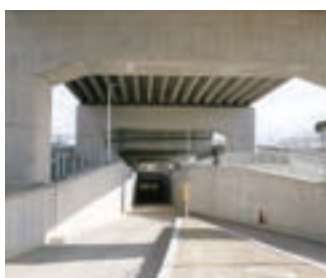
J R和歌山線・国道168号の地下をくぐるトンネル部分
