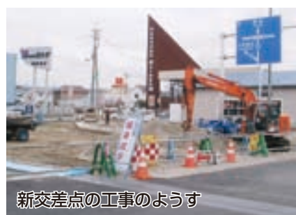
新交差点の工事の様子 奈良西幹線と国道168号との接合点 （交差点が新たに設置されます。）
