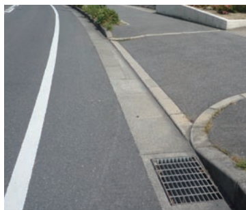
○切り下げ工事をされている箇所
