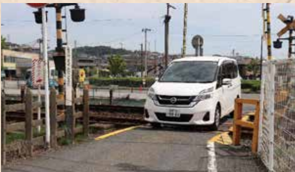
▲関屋第5号踏切（近鉄大阪線二上駅西側）の現状
