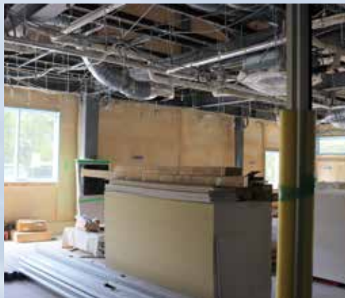
▲建設中の多目的室。児童の授業などが行えるようになる予定です。
