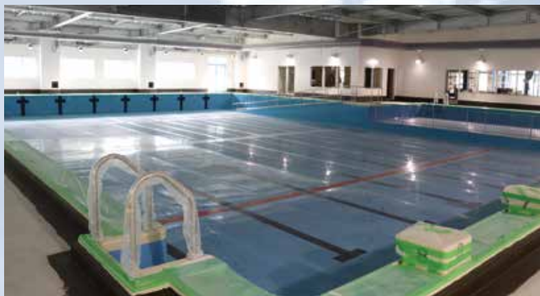
▲屋内温水プール(25m×8コース)
