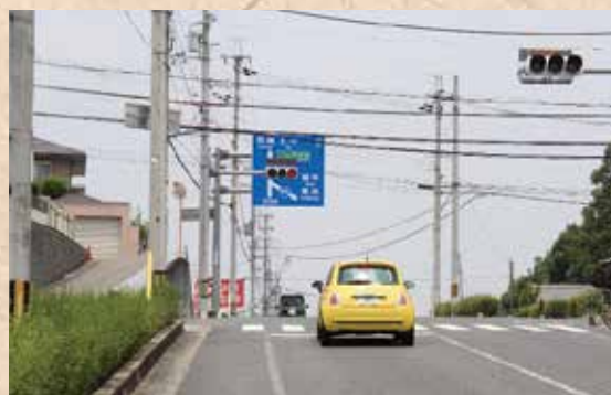
▲信号機と案内標識が重なっており、改善が必要な箇所
