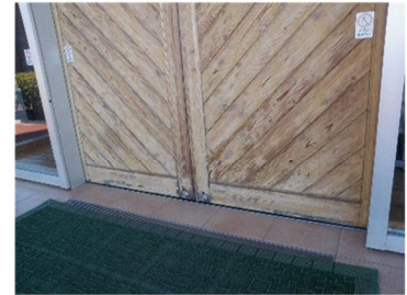
塗膜の剥がれに よる変褪色
