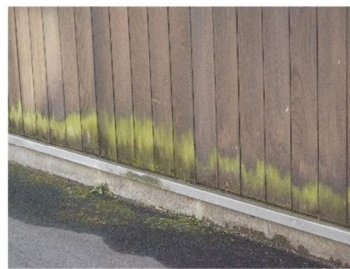
外壁での雨かかりによる 藻の発生
