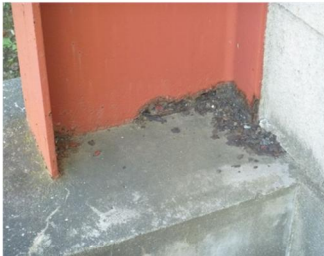
柱脚部の腐食
