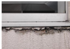
全体的に、変形・変質・さび・シーリングの硬化・ひび割れが見られる。
