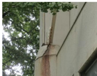
柱脚部台座の破損
