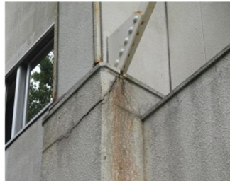
柱脚部台座の破損
