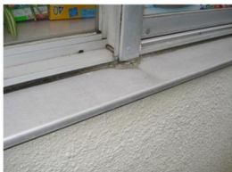
全体的に、変形・変質・さび・シーリングの硬化・ひび割れが見られる。
