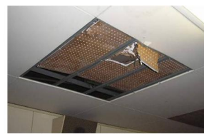
天井材の落下・剥がれ
