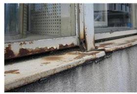
全体的に腐食・損壊・開閉不良があり、漏水がある。(D評価)
