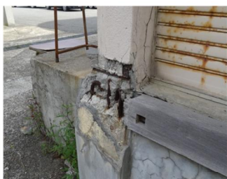
柱脚部の破損
