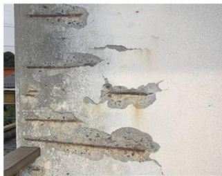
柱廻りの露筋
