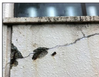
窓下の ひび割れ・剥落
