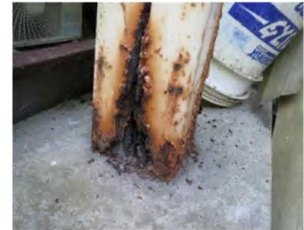
柱脚部の腐食
