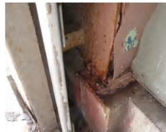
柱脚部の腐食
