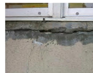
窓下の ひび割れ・剥落
