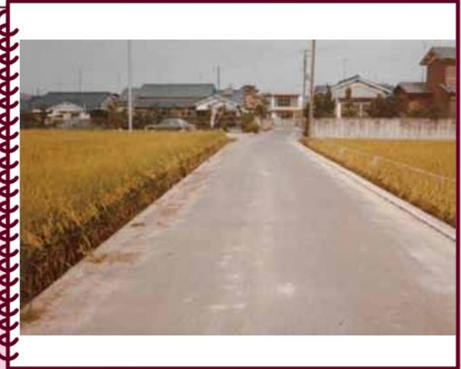
上下水道部保管写真
