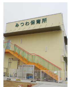
みつわ保育所1期工事の様子▶
