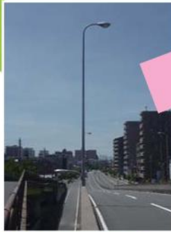
従来の道路照明灯
