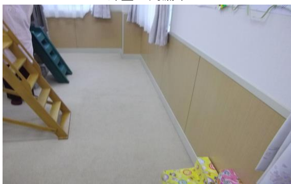
外壁の雨漏り
