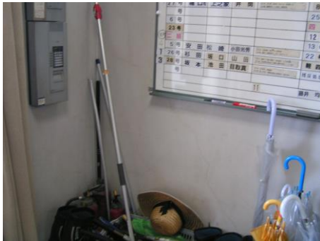
内部仕上げのひび割れ
