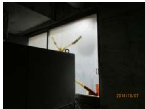
開口部の劣化
