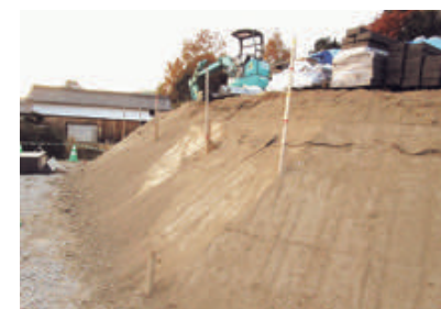
写真10 2段目テラスと墳丘盛土(東から)
