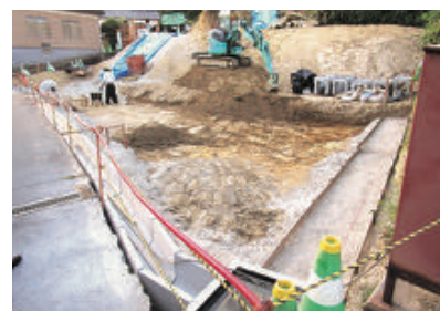
写真7 体験広場 U形側溝の敷設(南東から)
