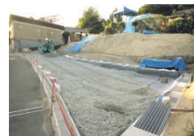
写真8 体験広場 雨水調整層(南東から)
