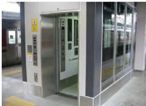
出典：香芝市バリアフリー基本構想 図 近鉄五位堂駅における構内エレベータの設置例
