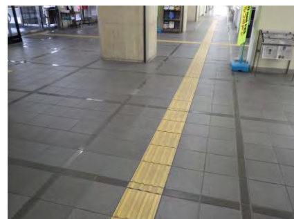
視覚障害者誘導用ブロックの設置・改良（識別しやすい色彩等の検討）（市役所 1F）
