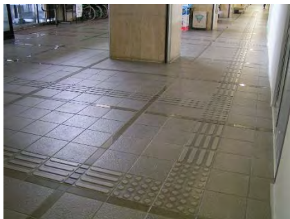
視覚障害者誘導用ブロックの設置・改良（識別しやすい色彩等の検討）（市役所 1F）
