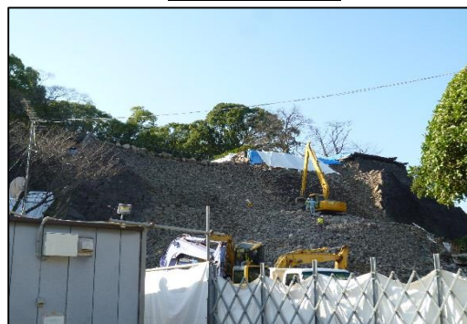
復興作業中の様子
