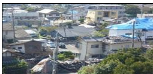
半壊・全壊した家屋（役場の屋上から）
