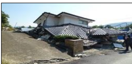
一階部分が倒壊した家屋
