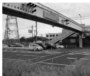
▲真美ヶ丘第1歩道橋
