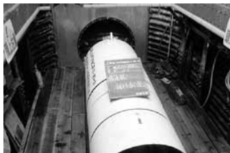
▲下水道管の設置工事
