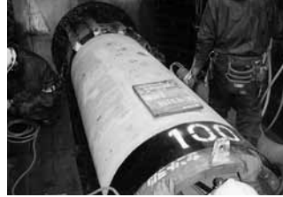
▲推進機を使って下水道管を設置
