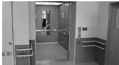
▲新保健センターのエレベーター
