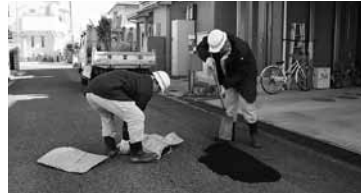
▲パトロールを行い、傷んでいる箇所を補修
