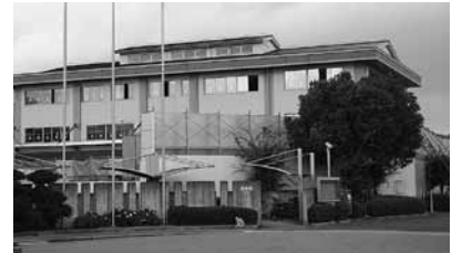
▲12月竣工予定の新しい保健センター
