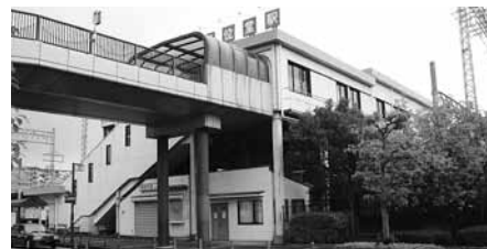
▲エレベーターの設置が予定されている五位堂駅北側
