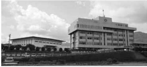
▲市役所庁舎(右)と総合体育館
