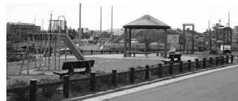
▲工事が進む区画整理事業地内
