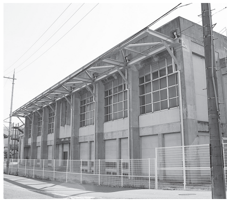
▲耐震工を実施した香芝中学校体育館
