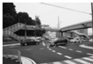
▲改良工事が行われている下田交差点
