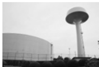
▲耐震補強工事を行った水道タンク
