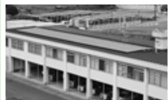
▲会議室棟の屋上に設置した太陽光発電パネル
