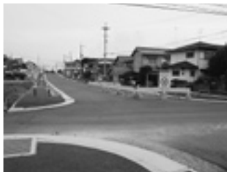
▲工事が進む奈良西幹線
