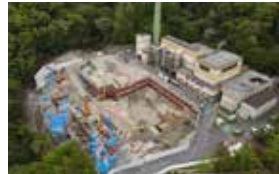
工事が進む美濃園
