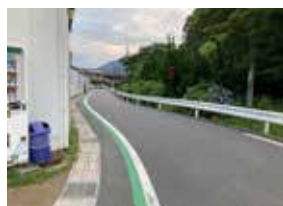
要望を受け改修された道路
