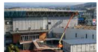
総合体育館耐震改修工事
