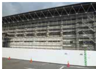
工事中の総合体育館
