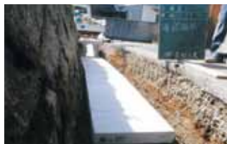
道路舗装工事
