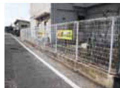
ブロック塀撤去後
