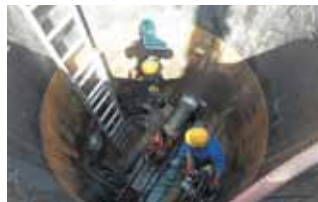
下水道工事の様子
