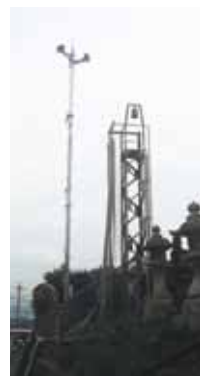
防災行政無線屋外スピーカー
