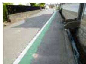
道路に設置されたグリーンベルト
