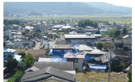
益城町役場屋上からの様子
