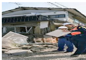
熊本地震の被災地で 行われている危険度判定
