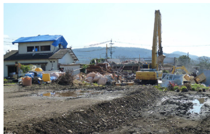
解体作業の進む家屋（益城町）
